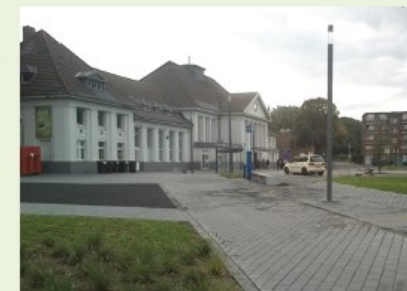
Bahnhofsvorplatz - Blick von Westen - nachher
